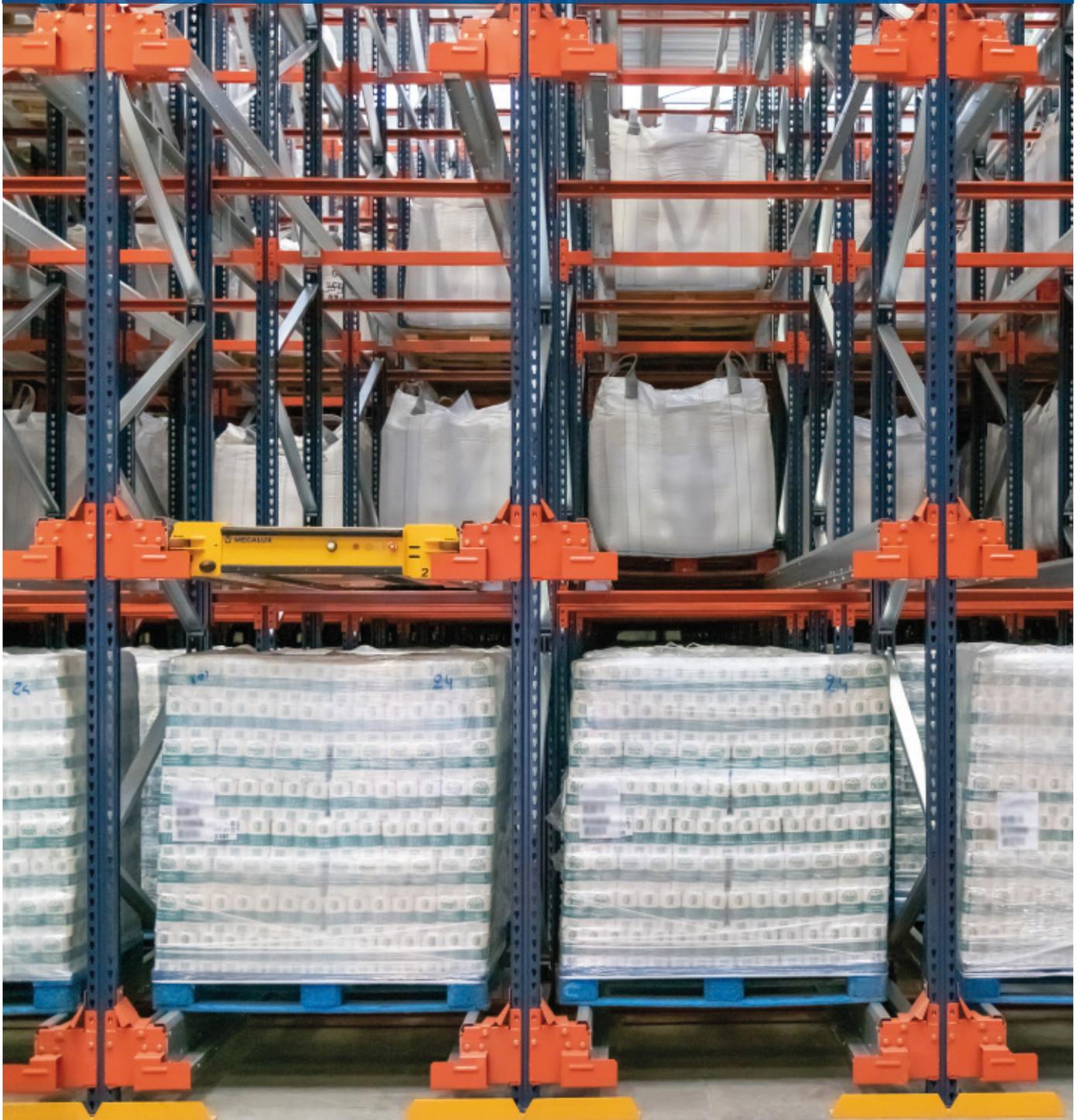
Zuidnatie, reconhecido operador logístico de Antuérpia, reorganizou a distribuição de um de seus armazéns em Antuérpia (Bélgica) com dois blocos de estantes que utilizam o sistema Pallet Shuttle semiautomático da Mecalux. A solução instalada proporciona uma capacidade de armazenamento para 2.875 paletes.
